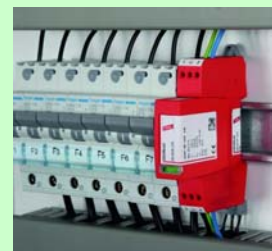
Innerer Blitzschutz (Überspannungen)
