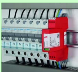
Innerer Blitzschutz (Überspannungen)
